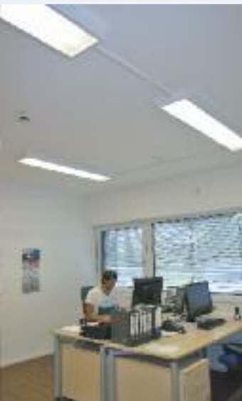
Für die Arbeit am PC geeignet: LED-Einbauleuchten blenden nicht
