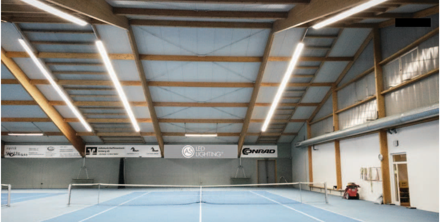
Tennishalle TC Kümmersbruck: 60 % mehr Licht, bei einer Stromersparnis von fast 70 %. AS LED Lighting half mit bei der Beantragung der Fördergelder.
