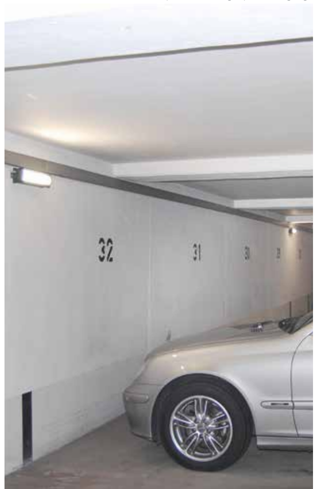
Stellplatzbeleuchtung in privater Tiefgarage
