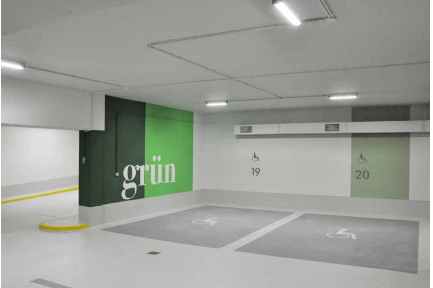
Stellplatzbeleuchtung mit Feuchtraumleuchte TGL
