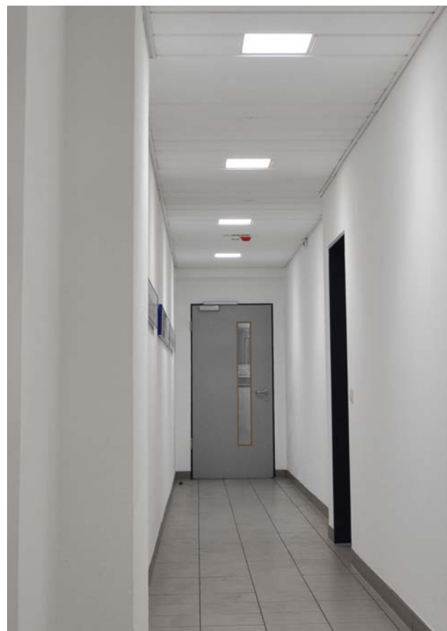
Einbauleuchte ESL in Büroflur-Systemdecke
