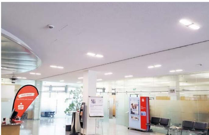
*Abb.: Die trapezförmigen Bestandsleuchten sollten aus architektonischen Gründen erhalten bleiben, aber energieeffizient modifiziert werden. AS LED Lighting fertigte hierfür passgenaue LED-Einsätze mit langer Lebensdauer.*
