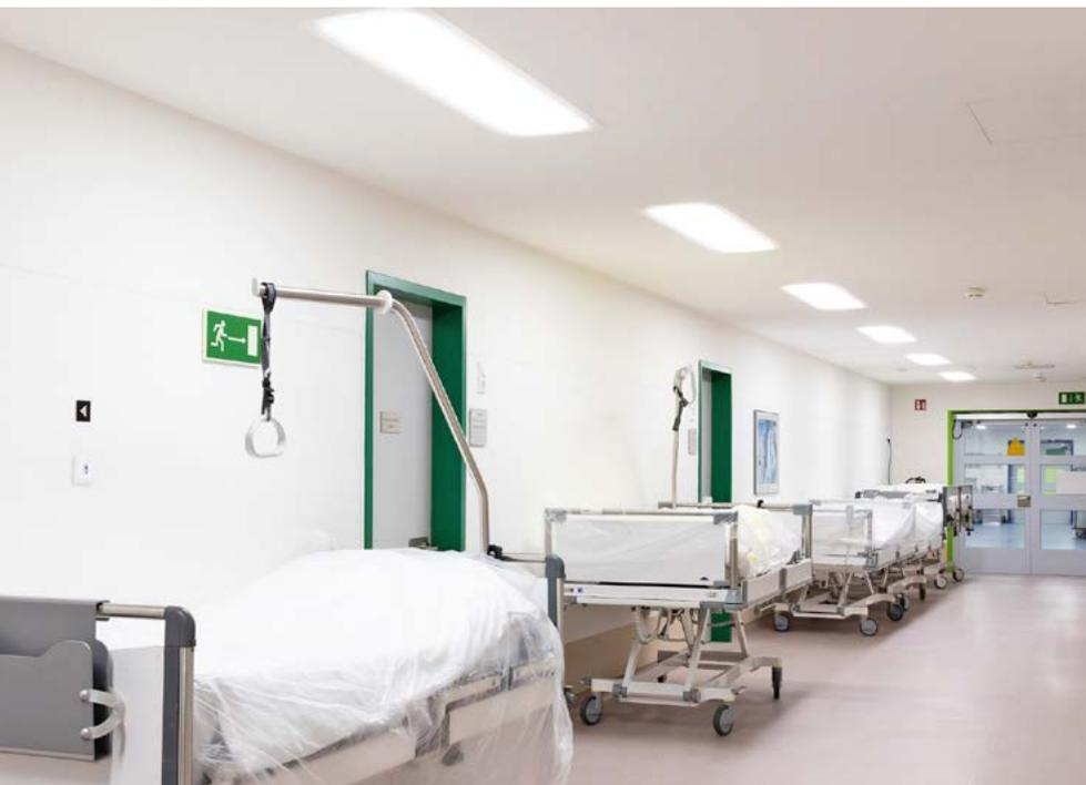
Speziell für das Hamburger Klinikum hat AS LED Lighting die Langfeld-Leuchterserie ‚EMO‘ entwickelt. Sie sind so flexibel konstruiert, dass alle Seitenteile an das benötigte Einbaumaß angepasst werden können.
