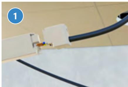
Netzteil durch Klick anschließen und in den Deckenausbruch legen.
