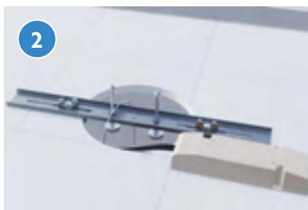
Befestigungsblech mit verstellbaren Schrauben seitlich arretieren. Ein am Befestigungsblech hängendes Metallseil sichert die Leuchte.
