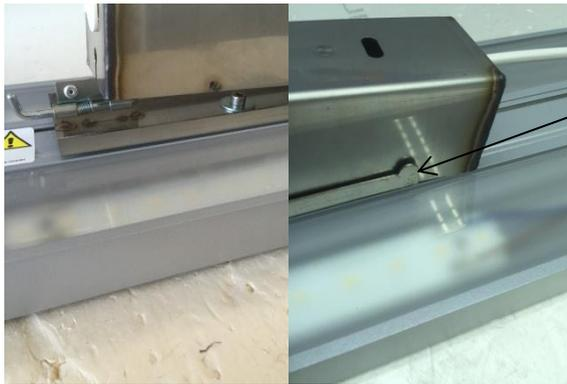
Leuchte schräg im flachen Winkel mit den Führungsschlitzen um das Deckengehäuse stecken.
