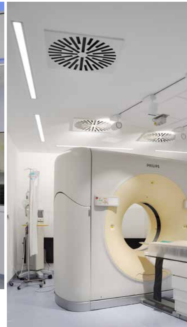
Raumadäquate Beleuchtung im CT-Bereich: Hohe Lichtleistung, stufenlos dimmbar, für einen optimalen störungsfreien Untersuchungsbetrieb
